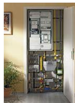
in Hausanschlussnischen (nur möglich bei nicht unterkellerten Gebäuden)
