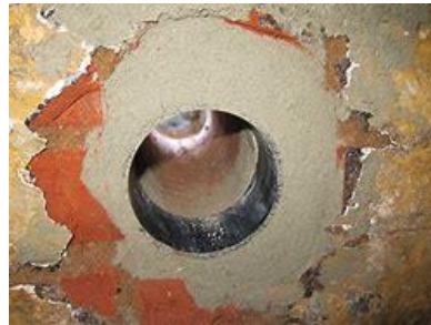
Beispiel 2: Einsatz eines Futterrohres in gemauerter Kellerwand
