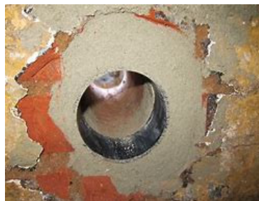
Beispiel 2: Einsatz eines Futterrohres in gemauerter Kellerwand
