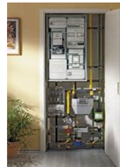
in Hausanschlussnischen (nur möglich bei nicht unterkellerten Gebäuden)
