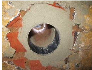
Beispiel 2: Einsatz eines Futterrohres in gemauerter Kellerwand
