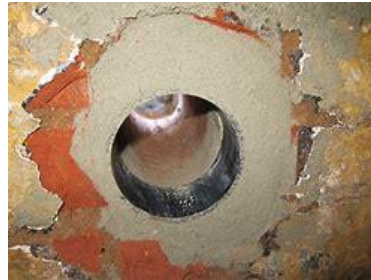
Beispiel 2: Einsatz eines Futterrohres in gemauerter Kellerwand
